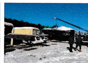
撤去作業の様子
